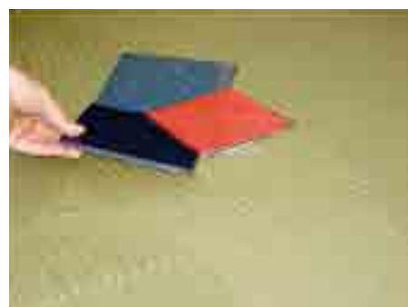
12. Nalożyć nasadę bez o-ringa i ułożyć płytki
